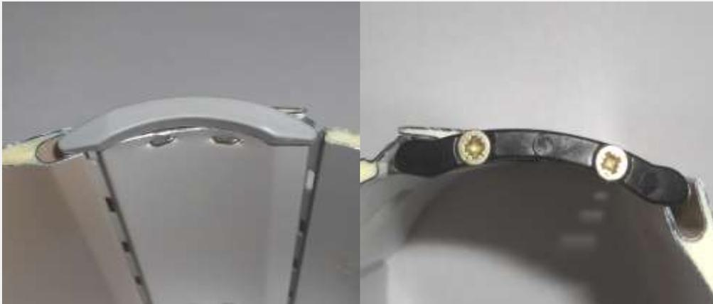
Im linken Bild sehen Sie die Arretierung bei einem PU-geschäumten Alu Rollladen. Hier wird der Arretierclip in den PU-Schaum gedrückt und mit einem Tacker festgeschossen.
