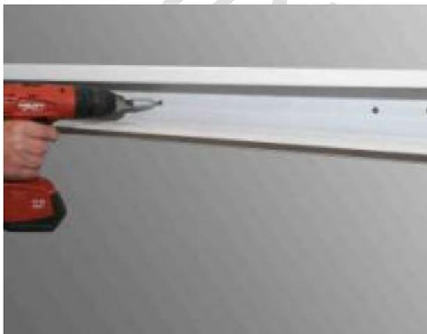
Kontrollieren Sie, ob Ihre Wand uneben ist und Sie u.U. diese Unebenheiten mit Unterlegstücken zwischen Profil und Mauerwerk ausgleichen müssen.
