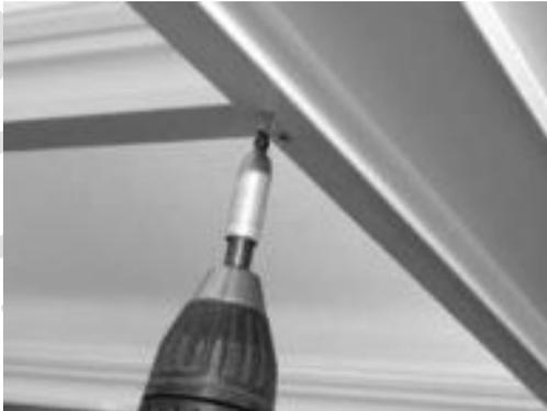
Durch die Unterseite des Längsprofils mit dem 3,5 mm HSS Bohrer Löcher in die Unterseite der Träger bohren (jeweils 2 Löcher pro Träger).
