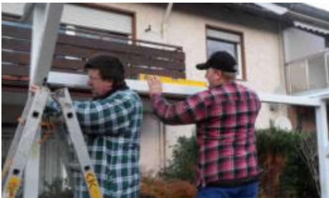
Mit der Wasserwaage loten Sie nun die genaue Befestigungshöhe an der anderen Seite aus.
