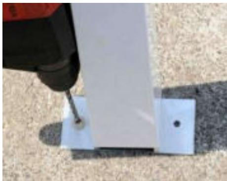
Die Vertikale aller Pfosten prüfen und anschließend die Fußstücke der Pfosten auf dem Untergrund befestigen.
