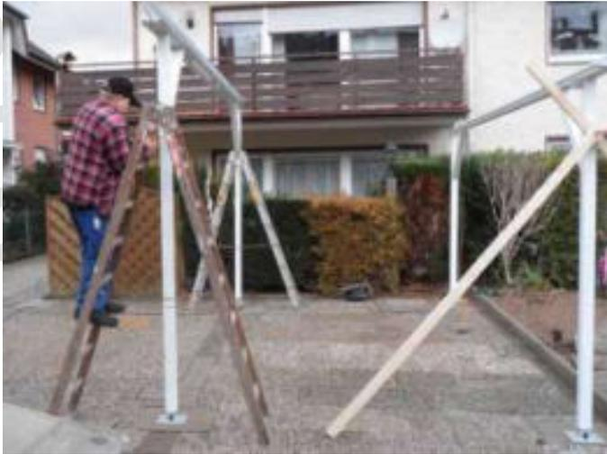
Um die unter Punkt 7 vorbereiteten beiden Längsprofil Anordnungen miteinander zu verbinden, empfiehlt es sich, beide mittels einer Hilfskonstruktion aufzurichten.
