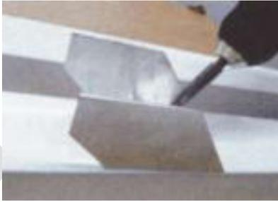
Auf die schräg angeschnittenen Alu Winkel können Sie nun auch schon die Schrägstücke aufsetzen und verschrauben.
