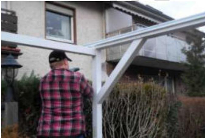
An der niedrigeren Längsprofil Anordnung sind die U-Profile, auf denen die Querstreben aufgesteckt werden, bereits in Bauschritt 5 an den Pfosten angebracht worden.
