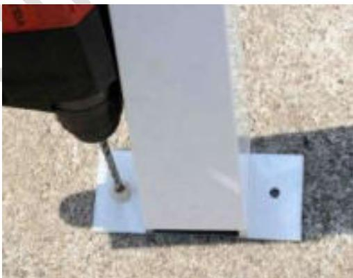
Die Vertikale aller Pfosten prüfen und anschließend die Fußstücke der beiden Eckpfosten auf dem Untergrund befestigen (Dübel und Schrauben sind nicht im Lieferumfang enthalten).
